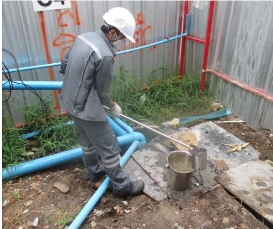
รูปที่ 2.57 ท่อระบายน้ำชั่วคราว เพื่อรวบรวมน้ำเสียลงสู่บ่อพัก
